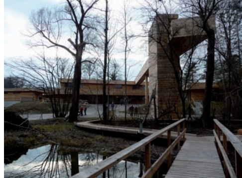
Abb. 14. Naturzentrum Thurauen mit dem Beobachtungsturm und dem über einen Steg geführten Rundweg. Aufnahme C. Marti.
