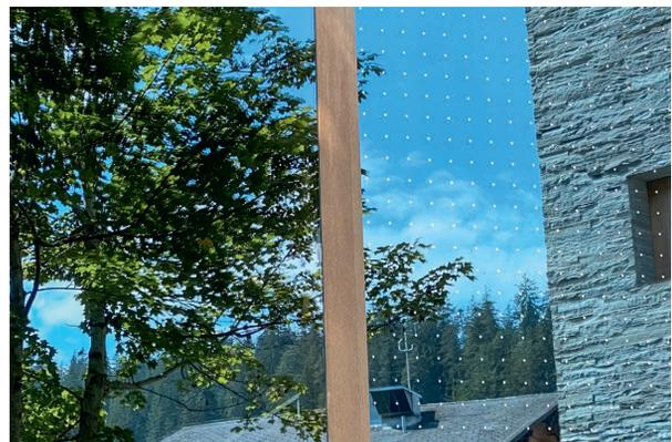
Eine mit «Seen Elements» versehene Glasscheibe an einem der Testgebäude in Laax GR. Mit den hochreflektierenden Aluminiumelementen schnitt das Produkt mit verhältnismässig geringem Bedeckungsgrad der Markierung bei Tests der biologischen Station Hohenau (Österreich) gut ab. Aufnahme Reto Fry.
