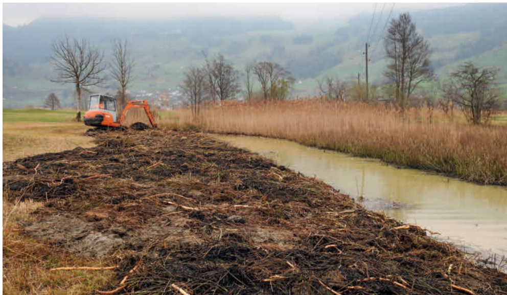
Abb. 12. Baggerarbeiten am Lauerzersee. Aufnahme vom 20. November 2018, P. Kühne.
