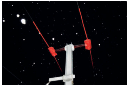
Abb. 26. In Zusammenarbeit mit der Vogelwarte hat die Rhätische Bahn RhB im Engadin erste gefährliche Fahrleitungsmasten isoliert und somit für Uhus stromschlagsicher gestaltet. Aufnahmen D. Jenny.
