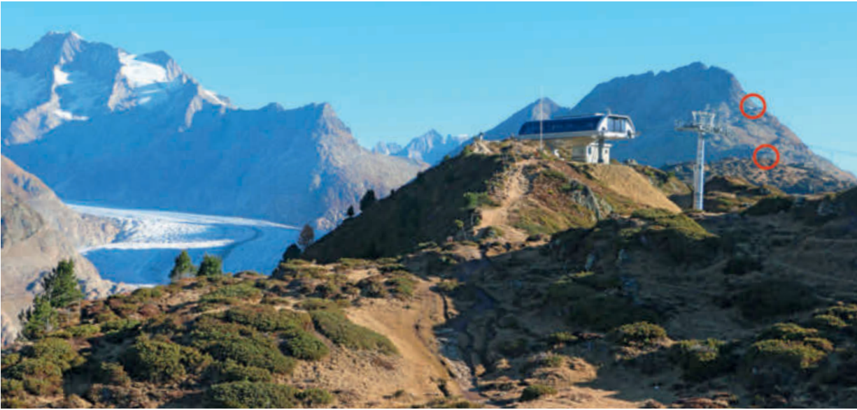
Abb. 5. Bergstationen von drei Transportanlagen im Bereich der Schneehuhn-Lebensräume; die westlichste (im Vordergrund) steht hart an der Grenze des Reservats Aletschwald. Aufnahme 17. Oktober 2017, U. N. Glutz von Blotzheim. – During the last 20 years, the terminals of three chairlifts or cable cars built near the home range of the Rock Ptarmigan population brought more tourists into this area than ever before.
