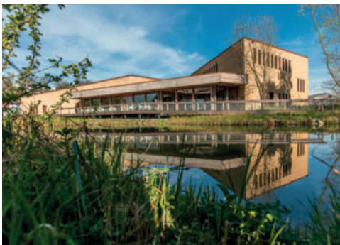
Abb. 1. Das Besuchszentrum besteht aus zwei Baukörpern aus Lehm und dem verbindenden Foyer aus Holz und wurde ausserhalb der Seeferschutzzone neu gebaut. Nicht nur das Gebäude, sondern auch die Ausstellung erfüllt die Anforderungen für minimalen Energieverbrauch und für die Verwendung von ökologischen Baumaterialien gemäss den Standards von Minerale P-Eco. Aufnahmen M. Burkhardt.
