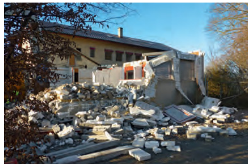
Abb. 16. Da kommt auch ein wenig Wehmut auf: Abbruch des Bibliotheksanbaus von 1980/81; das Hauptgebäude von 1954/55 ist schon geräumt. Aufnahme 13. Januar 2015, C. Marti.
