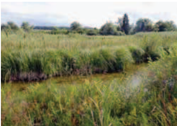
Abb. 6. Im Wengimoos laufen 2013 grosse Renaturierungsarbeiten an.
