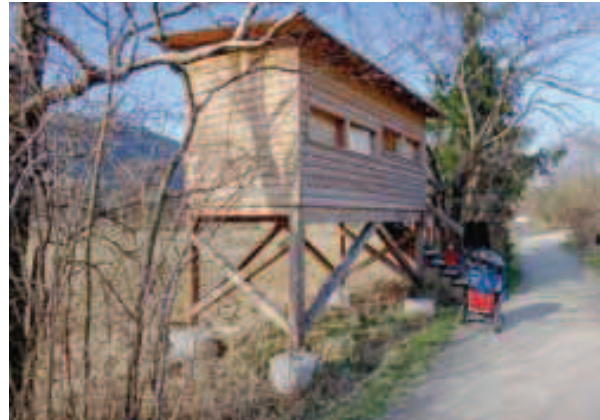
Abb. 9. Der neue Turm in der Weissenau. Die Rückseite Richtung NW gegen das Ried hin ist offen.
