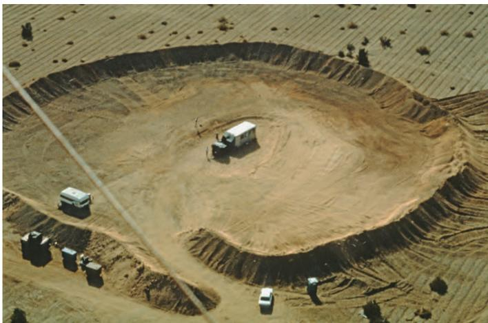
**Abb. 5.** Künstlich gebauter Damm in der Wüste des Arava-Tals (Israel, 1991), der den Radar gegen alle störenden Echos aus der Umgebung abschirmte. Weitere Abbildungen dazu in Bruderer et al. (2000). Aufnahme H. Stark. – *An artificially constructed dam in the desert of the Arava-Valley (Israel, 1991) screening off all ground-clutter from the surroundings. Further illustrations in Bruderer et al. (2000).*
