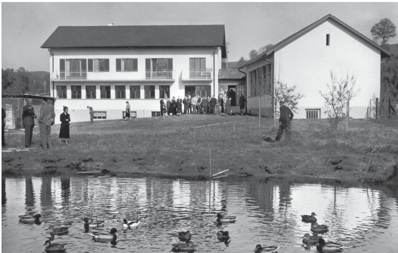
Abb. 6. Eröffnung des eigenen Vogelwarte-Gebäudes 1955. Rechts der bis heute im Wesentlichen unveränderte Vortragssaal. Das Hauptgebäude (links) enthielt im Erdgeschoss Büros, im 1. Stock zwei Wohnungen. Aufnahme Photopress, Zürich.
