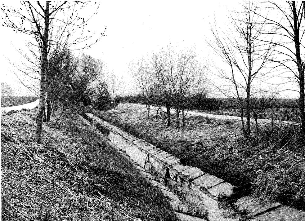
**Abb.4.** Südlicher Teil des Staadkanals mit Blick nach N. Der Kanal wird fast jedes Jahr bis auf die Betonplatten ausgebaggert. Auch die Büsche werden regelmässig erdünnert und z.T. auf den Stock gesetzt (Frühjahr 1990). – *Southern part of the canal. Bushes are cut regularly.*
