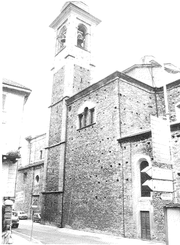
Abb. 1. Nordfassade der Kirche S. Antonio mit den von den Seglern bewohnten Mauerlöchern. Der Hauptteil der Fahlseglerkolonie befand sich im unteren Teil der 15,5 m hohen Wand rechts vom Kirchturm. Die wichtigste Reihe von Niststellen lag etwa 6 m hoch, ungefähr in der Höhe des oberen Randes des Bogenfensters vorne rechts. (Aufnahme R. Lardelli).
