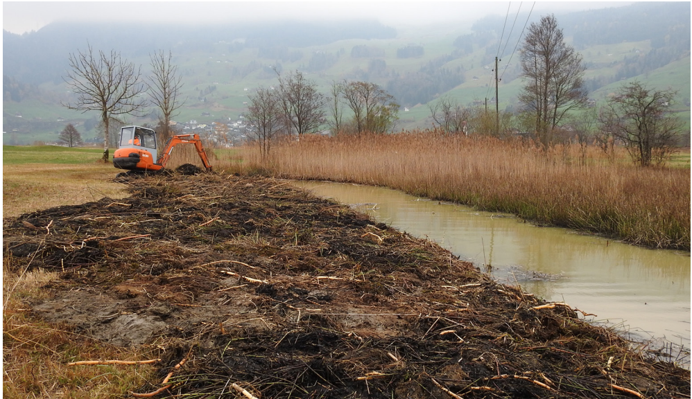
Abb. 12. Baggerarbeiten am Lauerzersee. Aufnahme P. Kühne.
