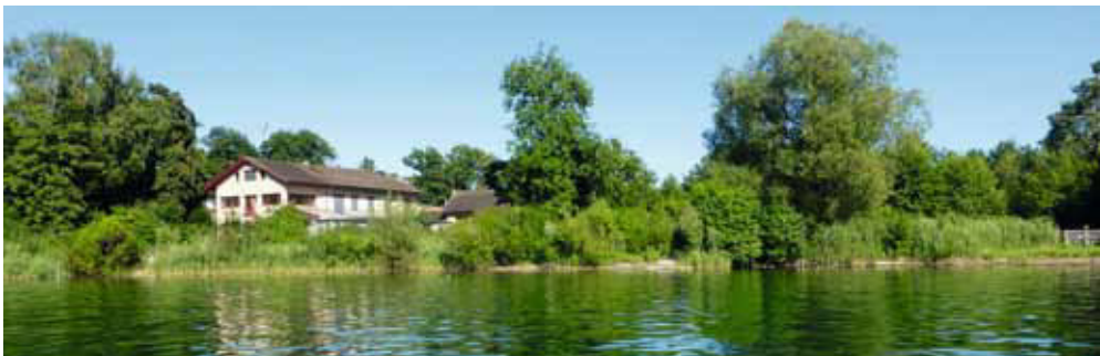
Abb. 12. Die 1954/55 errichteten, später erweiterten Gebäude der Vogelwarte vom See her, kurz vor dem Beginn der Arbeiten für das neue Besuchszentrum. Der Neubau wird rechts vom Altbau zu stehen kommen. Dieser wird im Winter 2014/15 abgerissen, worauf das Seeufer renaturiert werden kann. Aufnahme 1. August 2013, C. Marti.
