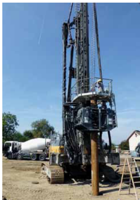
Abb. 14. Einbringen der Verdrängungs-Bohrpfähle. Das Metallrohr im Vordergrund, mit einem Durchmesser von 50 cm, wird bis zu 35 m tief in den Boden gepresst und während des Einfüllens von Beton wieder herausgezogen. Aufnahme 25. September 2013, C. Marti.
