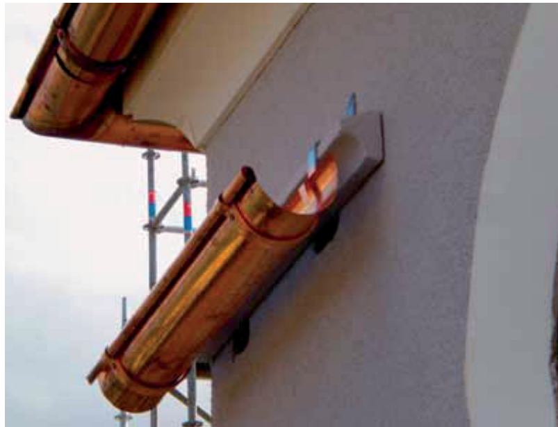
Abb. 3. Rinnen über den Höhleneingängen an der ehemaligen Knabenrealschule. Aufnahme 2. Mai 2011, H. Metzler. – At the beginning of May provisional gutters were fixed above the entrance of the substitute cavities in order to simulate the original breeding place.
