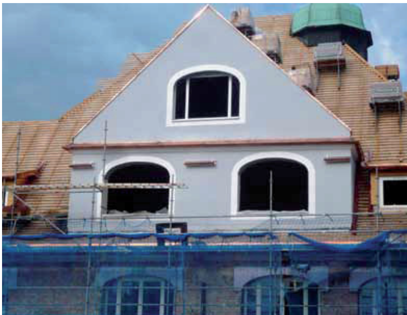
Abb. 2. Situation auf der Baustelle an der ehemaligen Knabenrealschule nach Rückkehr der Alpensegler. Aufnahme 14. Mai 2011, K. Harder. – Situation at the building site in May 2011 after Alpine Swifts had returned.
