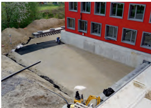
Abb. 6. Bau des Erdregisters. Hinten die später unterirdische Betonwanne, in die die Luft über drei Kamine eintritt. Die erste Lage von 17 je 30 m langen Rohren ist bereits überschüttet, von der zweiten Lage sind die Ansatzstellen sichtbar. Aufnahme 24. April 2009, C. Marti.
