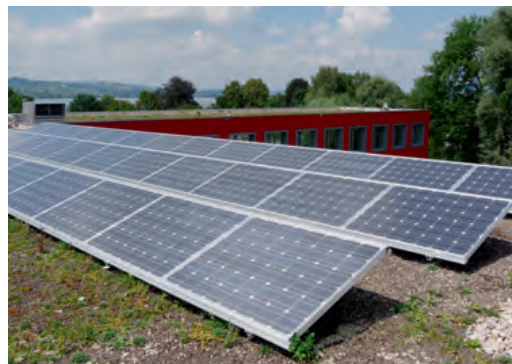
Abb. 7. Drei von sechs Reihen von Solarpanels der Fotovoltaikanlage auf dem Dach des Osttraktes. Über die Solarpanels hinweg ist die Ostfassade des Nordtraktes mit dem Seminarraum sichtbar, dahinter der Sempachersee. Aufnahme 4. August 2009, C. Marti.
