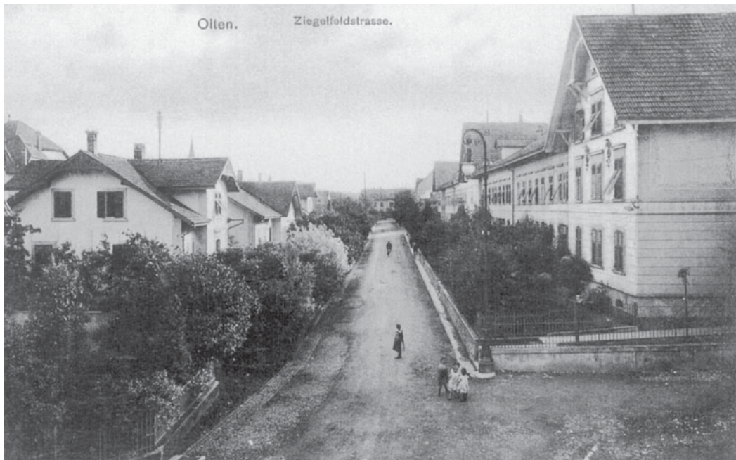
Abb. 5. Ziegelfeldstrasse in Olten um 1920. Das erste Haus links (Nr. 17) war Wohnhaus der Familie von Burg und Sitz der Eidgenössischen ornithologischen Kommission. – The von Burg family home in Olten (left) where the Federal Ornithological Committee had its seat.
