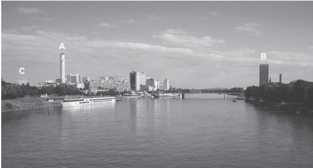
Abb. 1. Drei Wanderfalkenbrutplätze (nicht alle gleichzeitig besetzt) im Norden von Basel. A: erster Brutplatz (besetzt 1995–2003) am Hochkamin der IWB (105 m hoch), B: zweiter und 2003 gleichzeitig besetzter Brutplatz (2003–2005) am Novartis-Hochhaus (80 m hoch), C: dritter Brutplatz am Schweizerhall-Silo (72 m hoch, vermutlich 2004 und sicher 2005 besetzt). Distanz zwischen gleichzeitig besetzten Plätzen: A–B (2003): 520 m; B–C (2005): 1130 m. Aufnahme: M. Kéry, August 2005. – Three nesting sites of the Peregrine Falcon in northern Basel (not all simultaneously occupied). A: First nesting site (occupied 1995–2003) at the IWB chimney (105 m tall), B: second nesting site, simultaneously occupied in 2003 (and also 2004–2005), at the Novartis building (80 m tall), C: third nesting site at the Schweizerhall silo (72 m tall, occupied presumably in 2004 and certainly in 2005). Distance between simultaneously occupied sites: A–B (2003): 520 m; B–C (2005): 1130 m.
