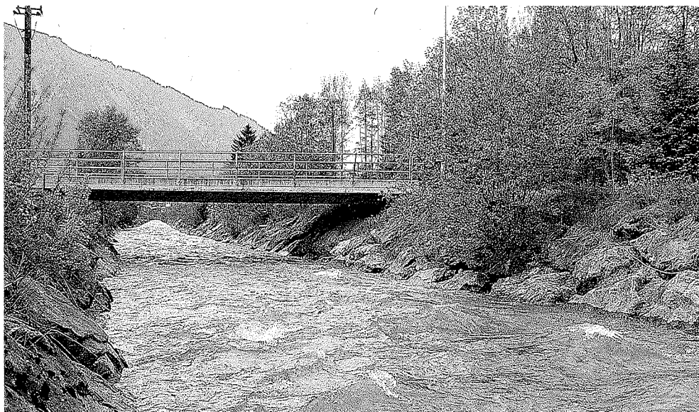
Abb. 1. Die «Rauchschnalbenbrücke» an der Lenk (Blickrichtung flussabwärts). Die Nester sind an die wegen der Zurückversetzung dunkel scheinende Betonwand geklebt (quer zum Fluss verlaufende, tragende Struktur unter der Fahrbahn). 25. Mai 1992.
